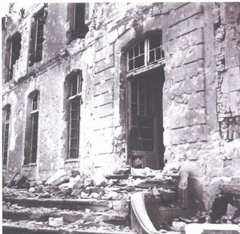
L'entrée ravagée du château depuis l'escalier
